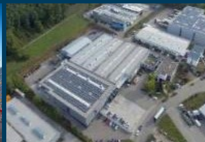
Göppinger Straße 1 - 3 Pforzheim, Germany
