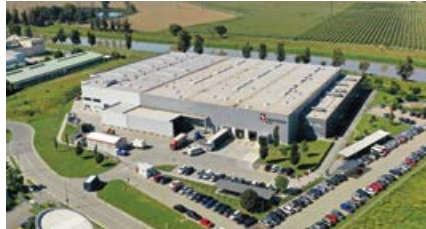
2 Moravia Industrial Park, Uherské Hradiště
