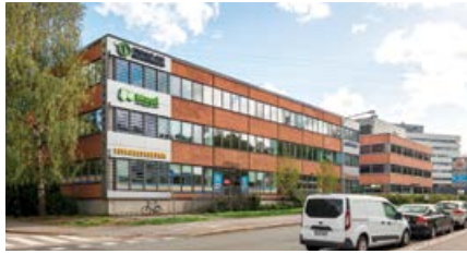
5 Mäkitorpantie 3b, Helsinki
