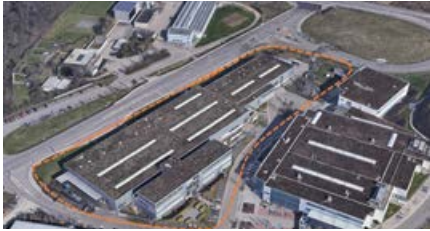
4 Göppinger Straße 1 - 3, Pforzheim
