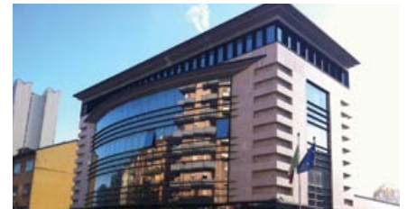
17 Via Rampa Cavalcavia 16-18, Venice Mestre
