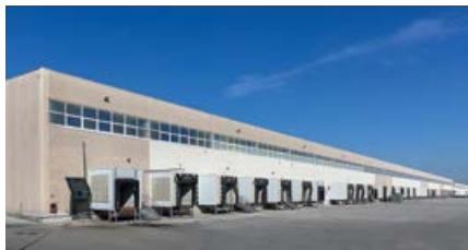
5 Strada Provinciale Adelfia, Rutigliano
