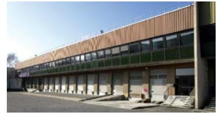
12 Parc Locaparc 2, Vitry-sur-Seine
