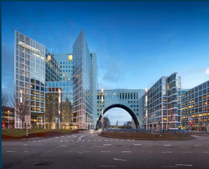
Haagse Poort Den Haag, The Netherlands
