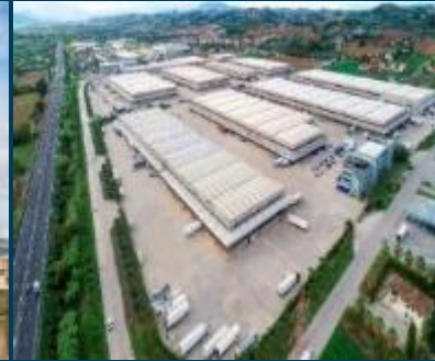
Centro Logistico Orlando Marconi (CLOM)
