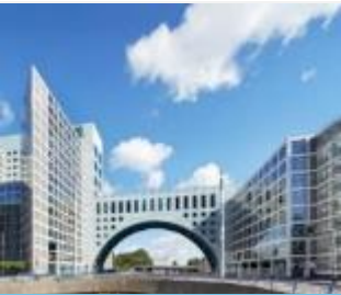
Haagse Poort Den Haag, The Netherlands
