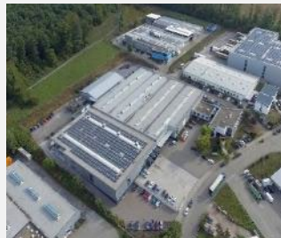
Göppinger Straße 1 – 3 Pforzheim, Germany
