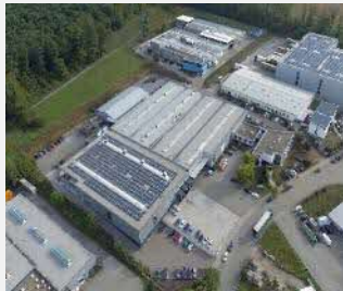
Göppinger Straße 1 – 3 Pforzheim, Germany
