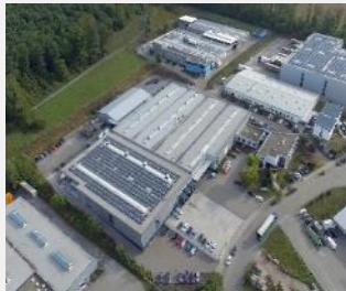
Göppinger Straße 1 – 3 Pforzheim, Germany
