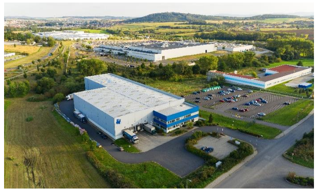
Písek Eta CZ Asset
