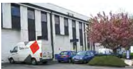
19. Parc Jules Guesde, 1 allée du Chargement, rue Jules Guesde, ZAC du Tir à Loques, Villeneuve D'Asq
